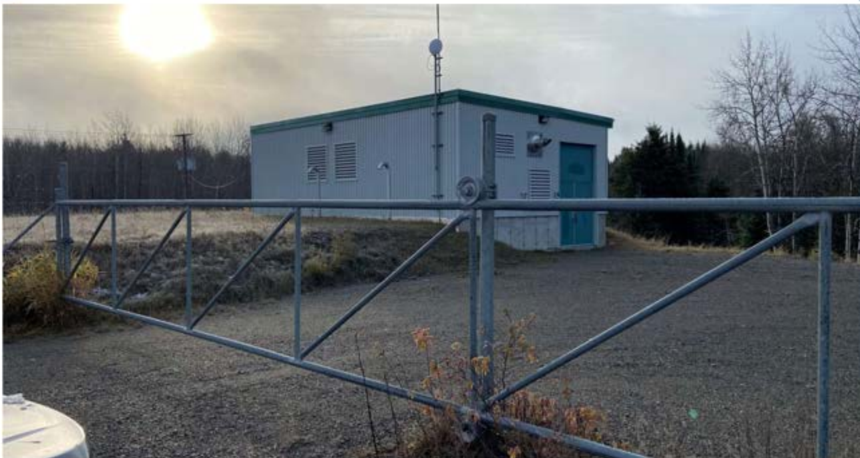
Station de pompage/traitement et réservoir de transit
