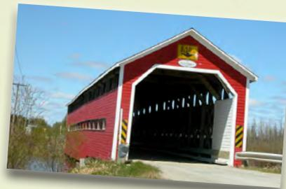
Le Pont de la Calamité, d'une longueur de 37,5 mètres (122 pieds) tire son nom de la rivière qui vit passer plus d'un incident malheureux. Comme le Pont Leclerc, il a été bâti en 1927 et les pièces du treillis sont vissées, une particularité des ponts de la région. Il traverse la rivière Desmeloizes.
